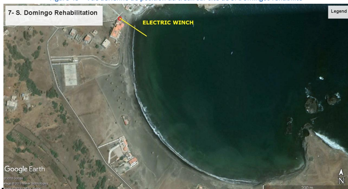
Figure 48 - Vue aérienne de position du treuil sur site de S. Domingos réhabilité
